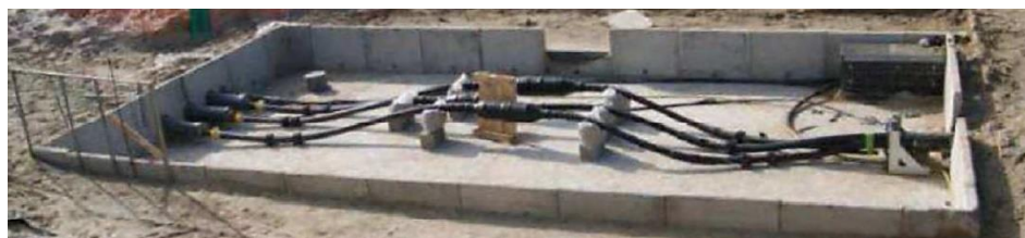
Figure 6 : Exemple d'une jonction d'atterrage avant son comblement. Source : RTE
