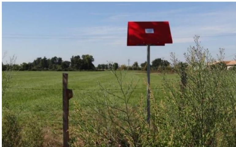
Figure 12 : Exemple de balisage existant pour une liaison souterraine. Source : RTE
